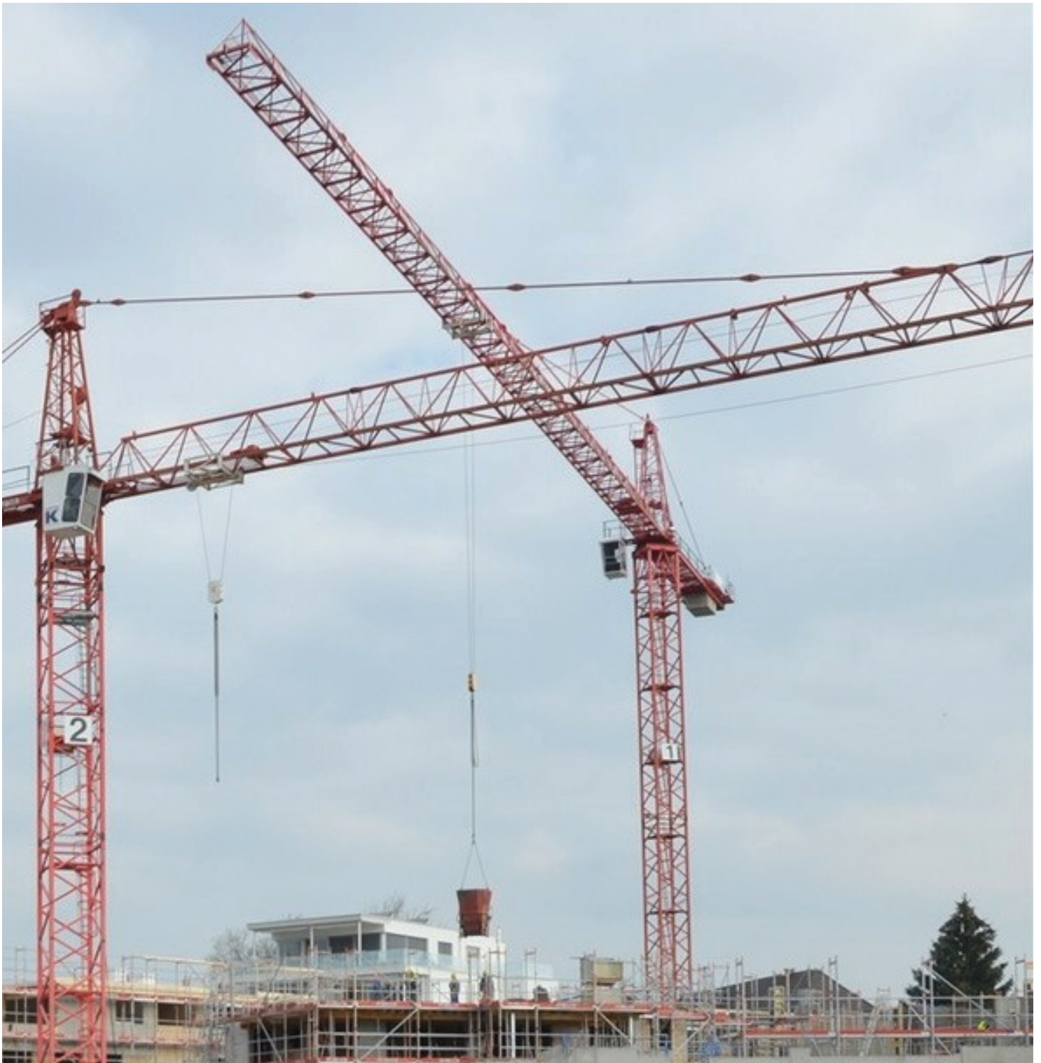
Abbildung: Baustelle Wohnpark Steindler, Wohlen, Aargauer Zeitung (26.3.2016)
